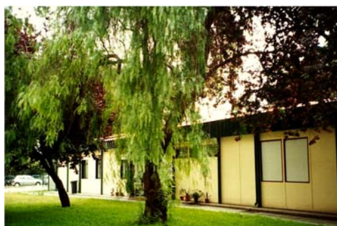
Fig. 1 – Pavilhão da Unidade de Neurodesenvolvimento
